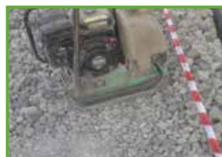
Come strato di separazione al contatto con il terreno viene posto "a letto" della ghiaia in vetro cellulare un geotessile (150-200 g/m<sup>2</sup>). Il riporto di **Savelpor 50** soprastante deve essere contenuto lateralmente dal terreno, o cordolature in pietrisco o ghiaia, o con assi di una cassaforma per permettere una idonea costipazione.
